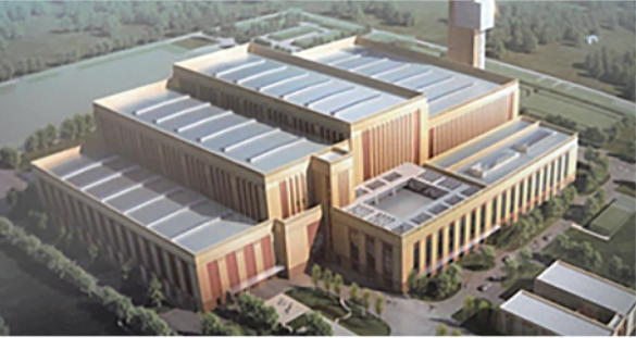
上海天马生活垃圾焚烧处理厂(炉排炉)
