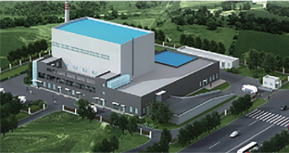
温州生活污水污泥干化焚烧厂(流化床)
